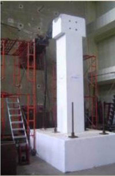
施工架內爬梯不完整
